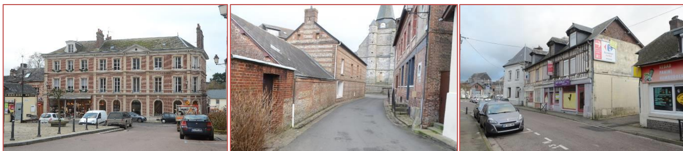
Figures 5, 6 et 7 : Immeubles du centre-ville
