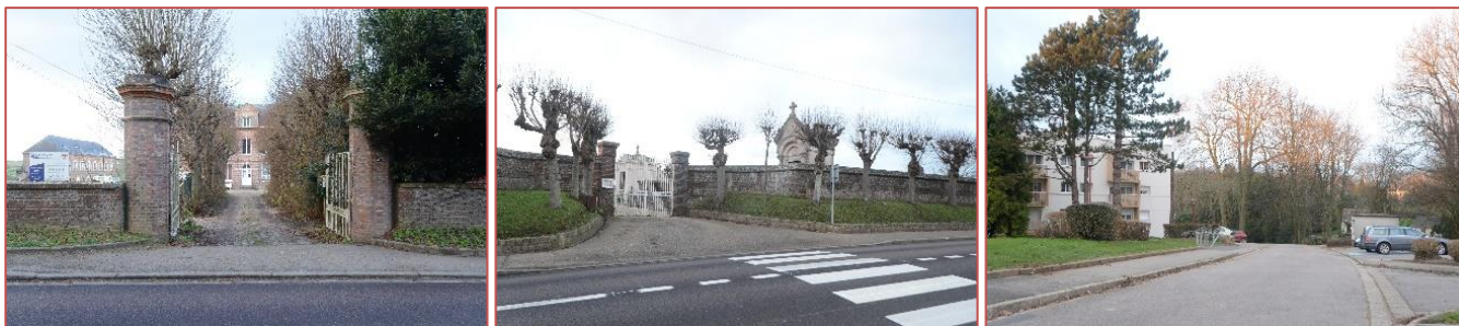
Figures 12, 13 et 14 : Portail d'une maison de maître / clôture du cimetière / parc boisé du Vert Galant
