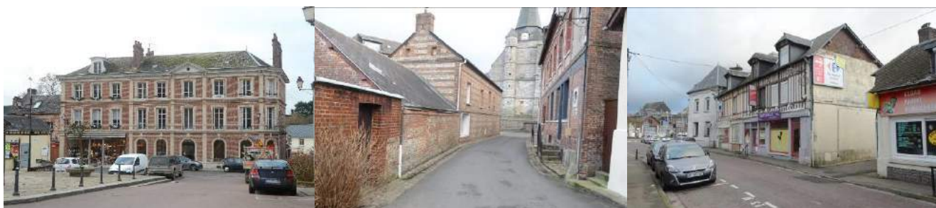
Figures 87, 88 et 89 : Immeubles du centre-ville
